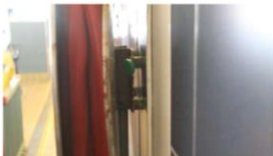
Ophangconstructie van de brandslang is magnetisch en niet vervaardigd van resistent roestvaststaal
