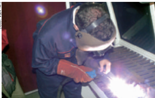
Bij RVS lassen wordt gebruikt gemaakt van een gevulde draad. Hiermee is slepend lassen mogelijk en wordt een behoorlijk grote inbrandingsdiepte gehaald. Het procédé is geschikt voor het lassen van staalplaat met een dikte van 16 mm of meer. Gunstig is ook dat er weinig nabewerking nodig is en dat de oxidatie gering is.
