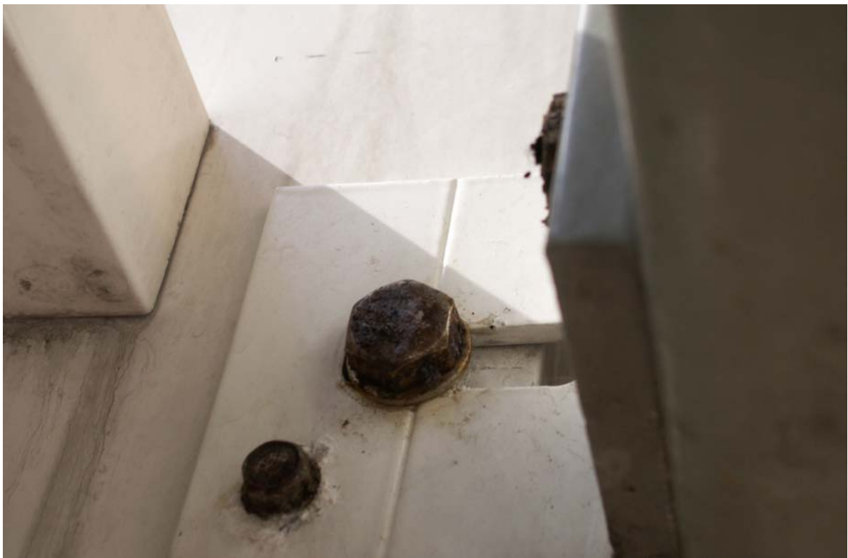
Weer RvS bouten die onder spanning staan in constructie
