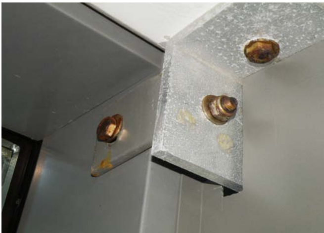
Roestvaststalen bouten in stalen constructie gebouw
