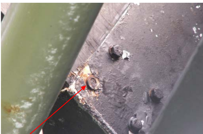
Kop bout weg en spanningscorrosie in draadeinden
