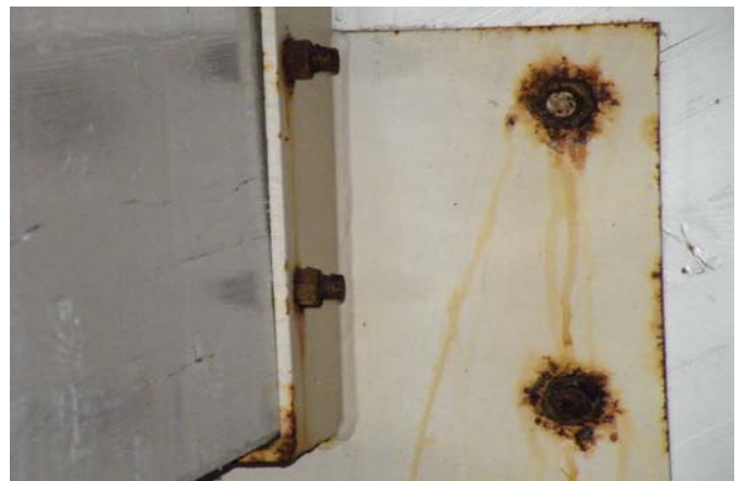
Roestvaststalen bouten in stalen dragers constructie van gebouw
