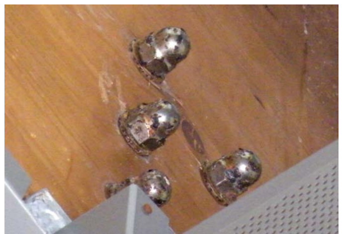
Roestvaststalen bouten in constructie zware houten panten
