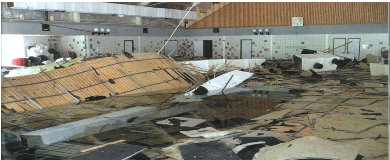
Zwembad te Steenwijk oorzaak spanningscorrosie in RvS draadeinden
