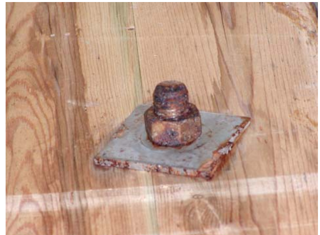
Spanten met verroeste RvS bouten gekoppeld
