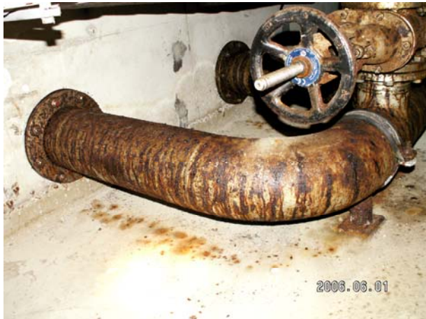
RvS leiding lost op en zwembad loopt leeg in kelder
