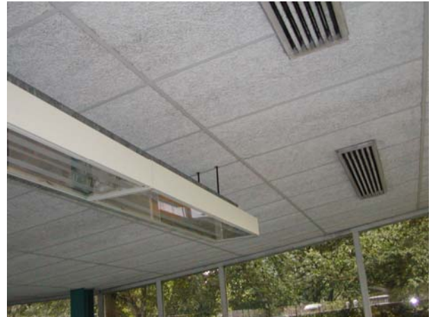
Zware TI armaturen, verroeste RvS draadeinden
