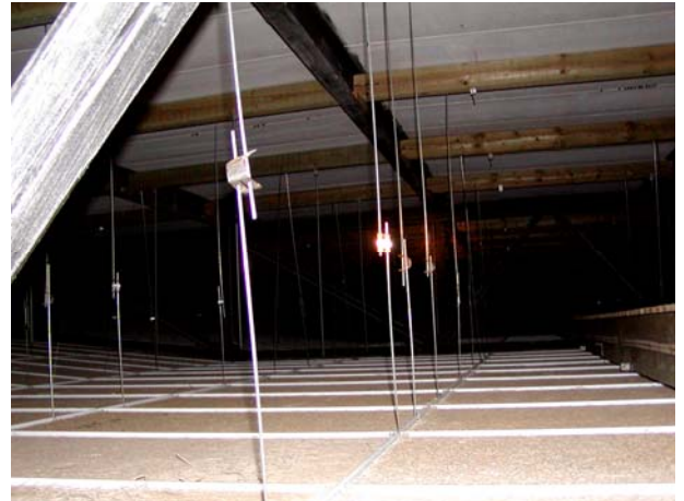
Controle boven plafond
